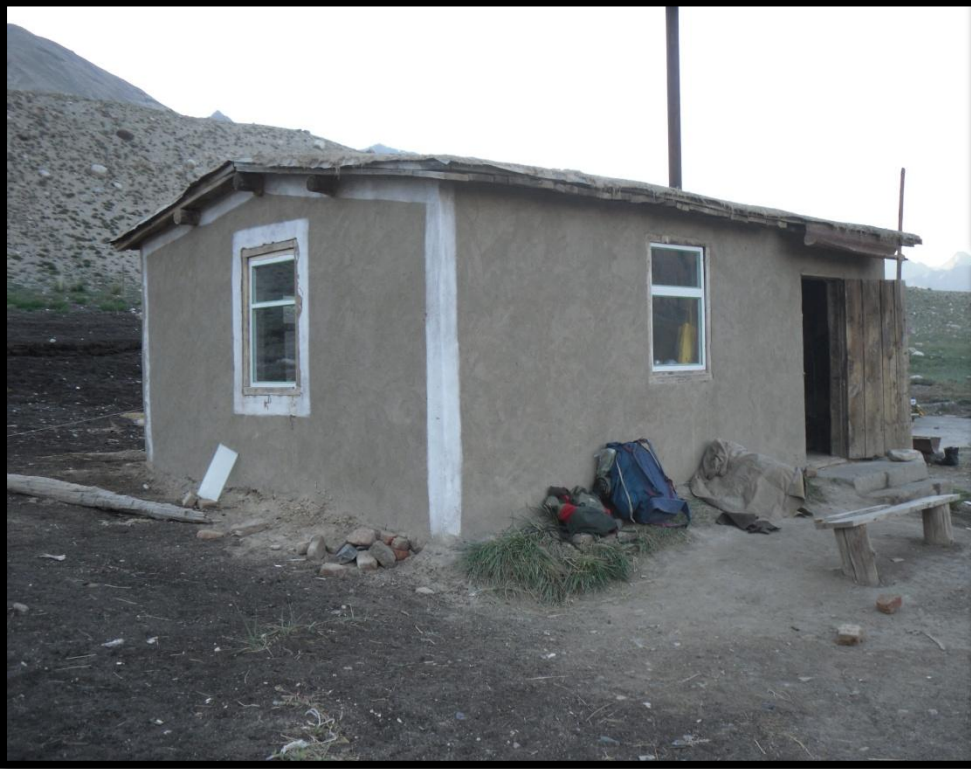
Résultats après les travaux
