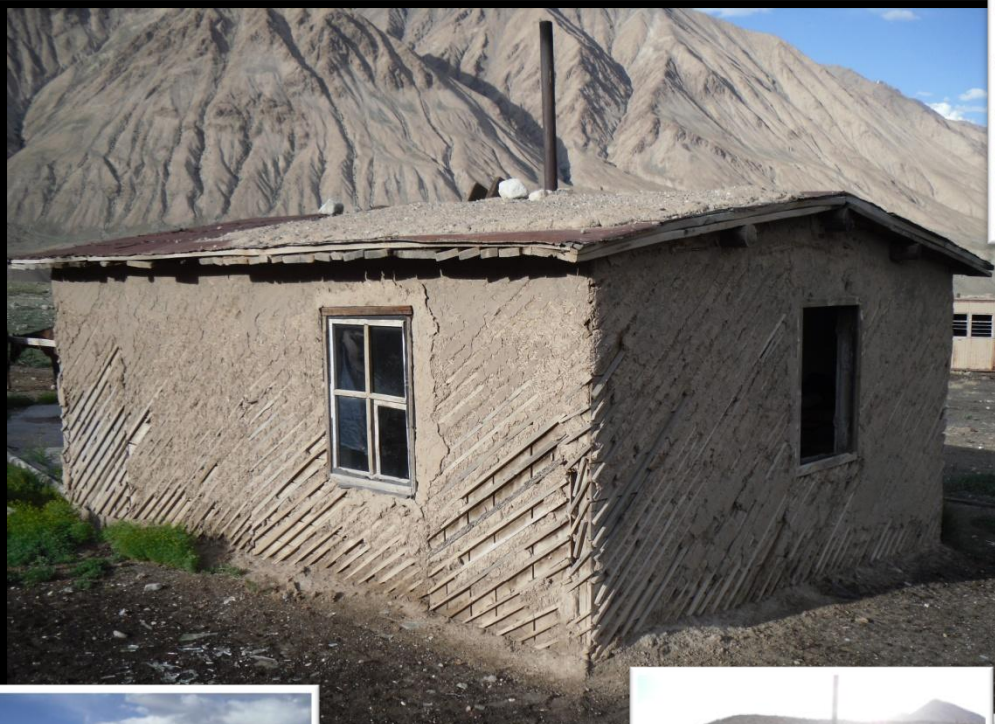
Vue globale de la maisonnette avant les travaux
